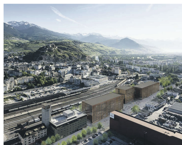
Ein Ort der Innovation: der Energypolis Campus in Sitten.
